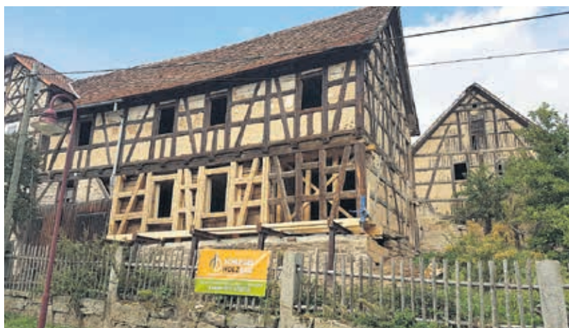
Altes Haus, Straßenseite, Sanierte Fachwerkwand
